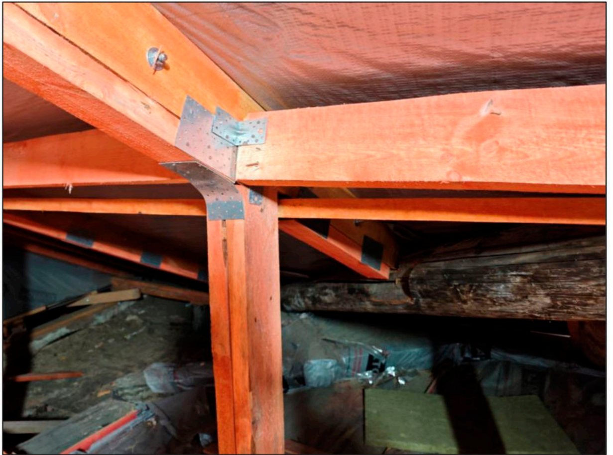
Фото 5. Общий вид узла крепления прогона.
