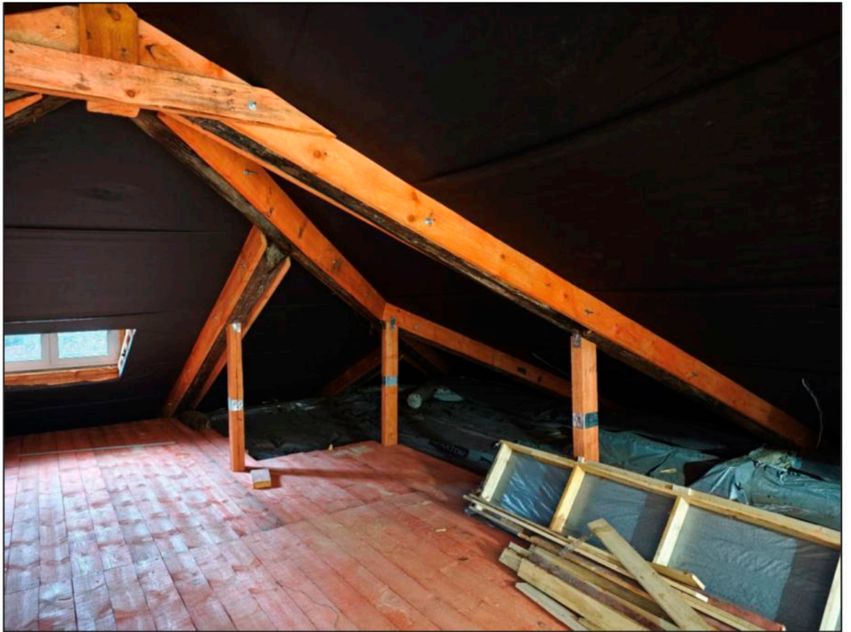
Фото 1. Общий вид стропильных конструкций Объекта экспертизы.
