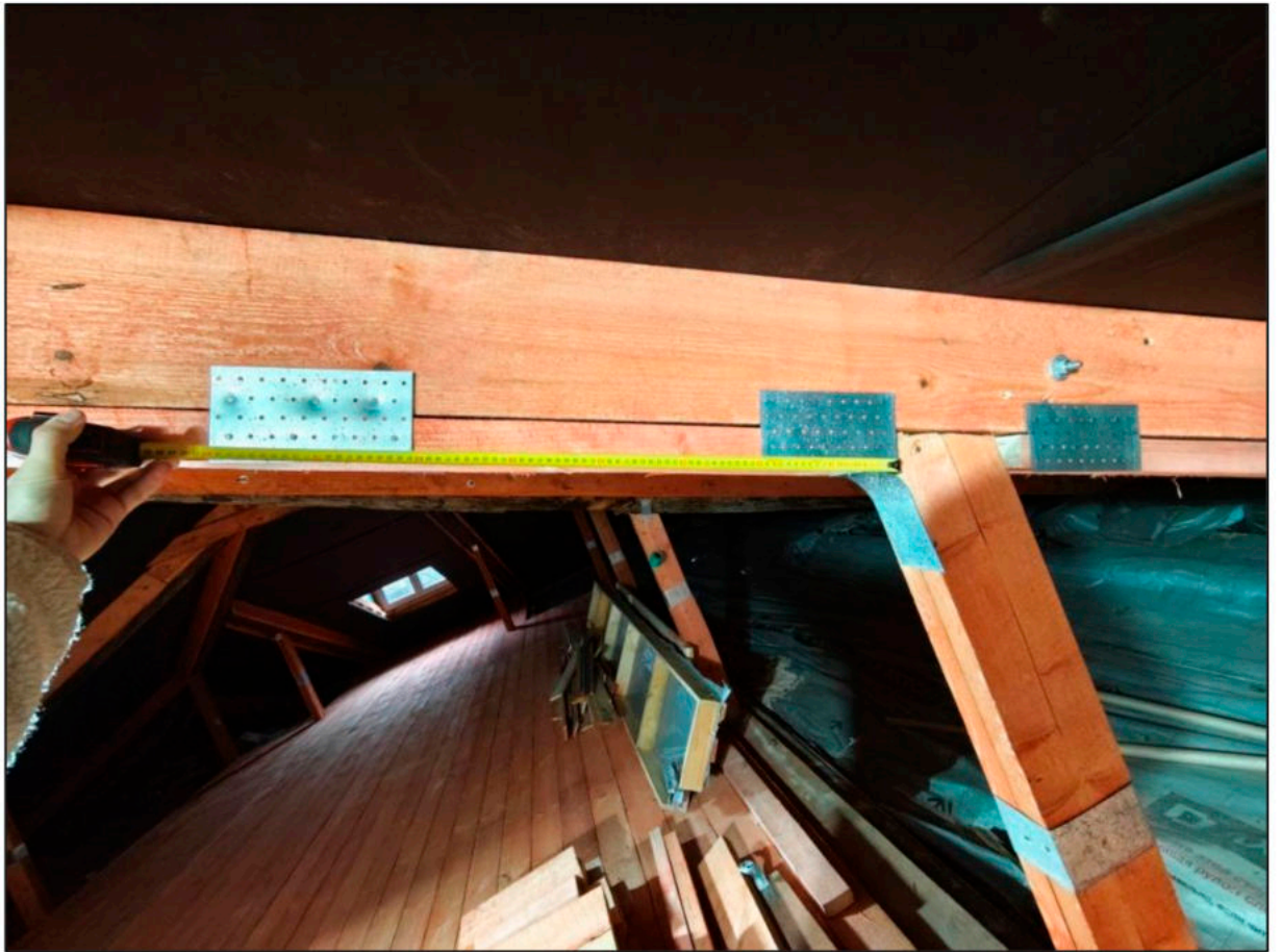
Фото 9. Определение шага соединительных пластин.
