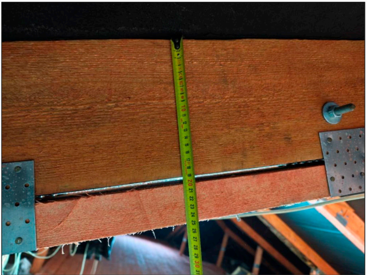
Фото 10. Определение геометрических параметров усиленной стропильной ноги.
