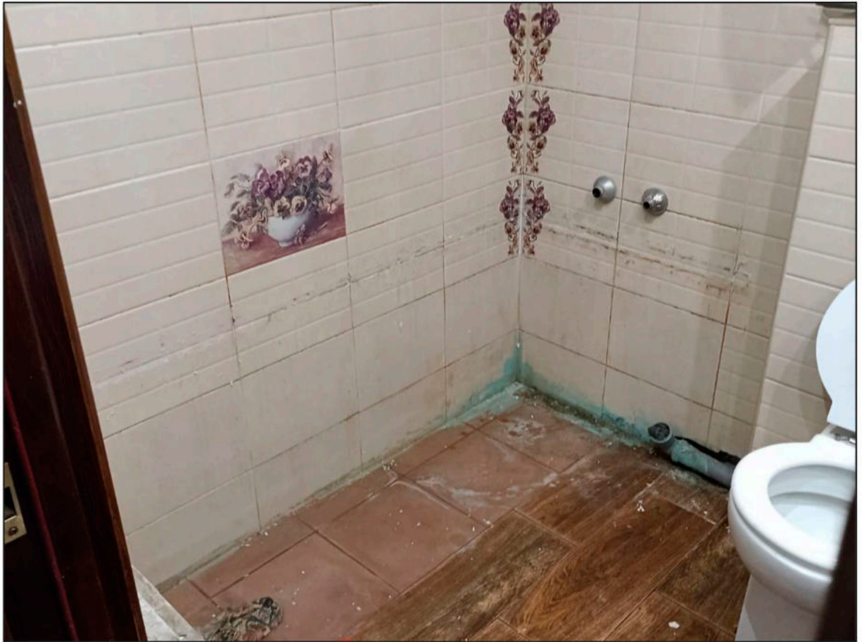
Фото 1. Общий вид участка под ванной после демонтажа.
