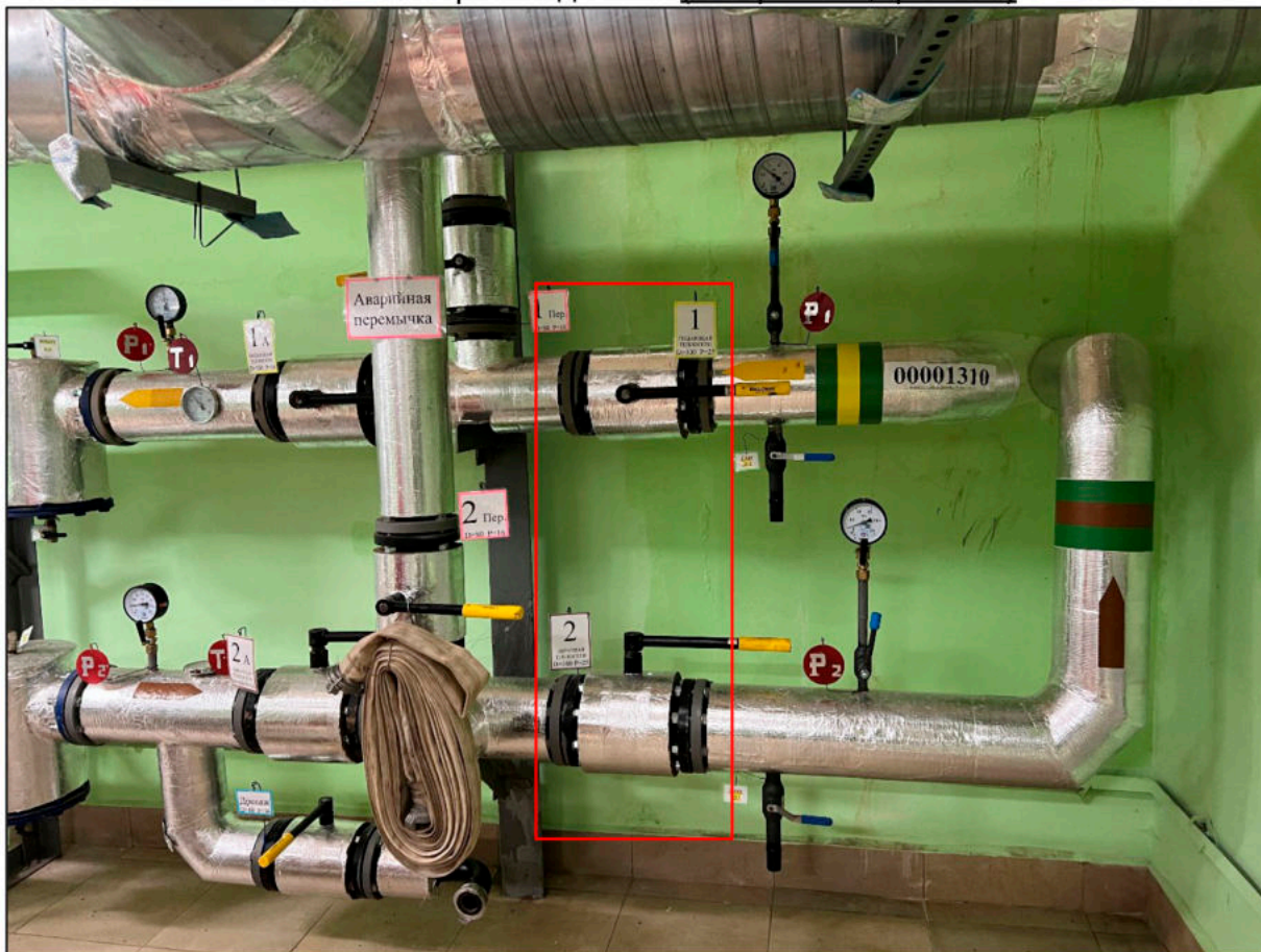
Фото 14. Общий вид задвижек Т1-«ввод» и Т2-«обратка»
