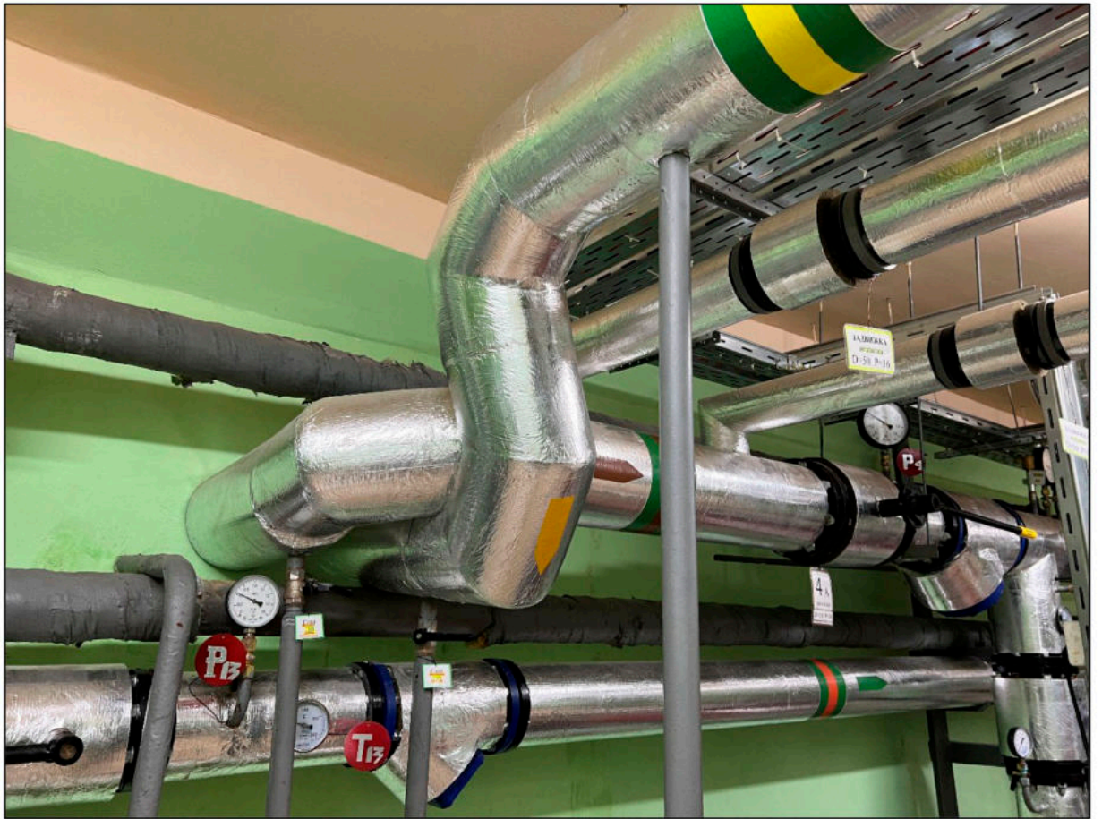
Фото 20. Соприкосновение теплоизоляции.
