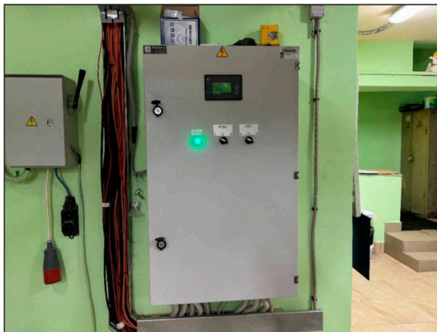
Фото 16. Шкаф автоматизации.
