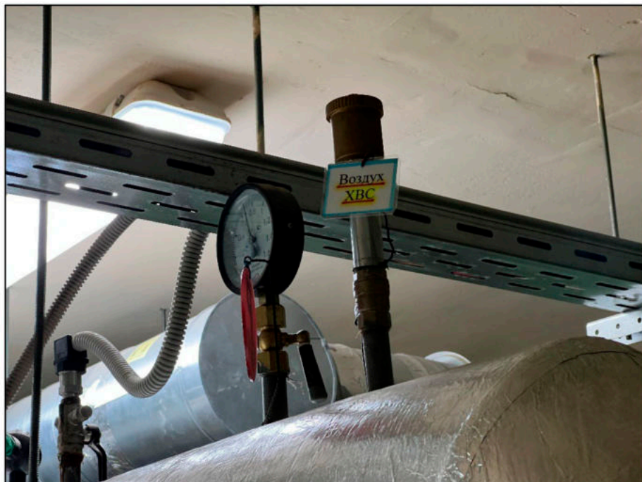
Фото 9. Манометр DN=100 на высоте более 2м.
