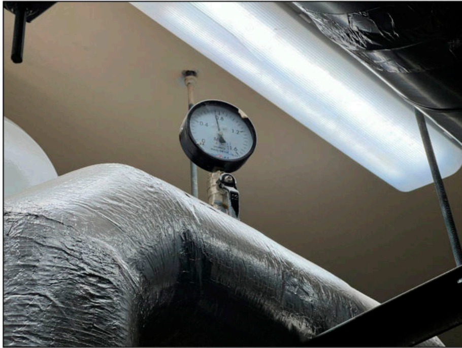
Фото 10. Манометр DN=100 на высоте более 2м.
