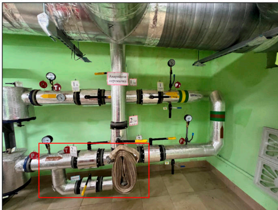
Фото 7. Дренаж в зоне узла ввода.
