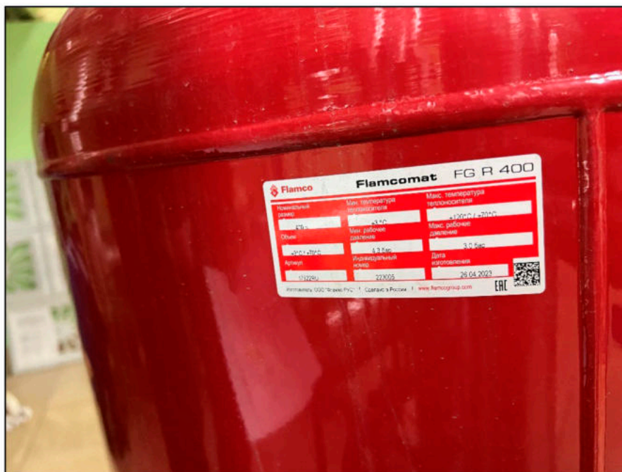
Фото 4. Смонтированный расширительный бак.
