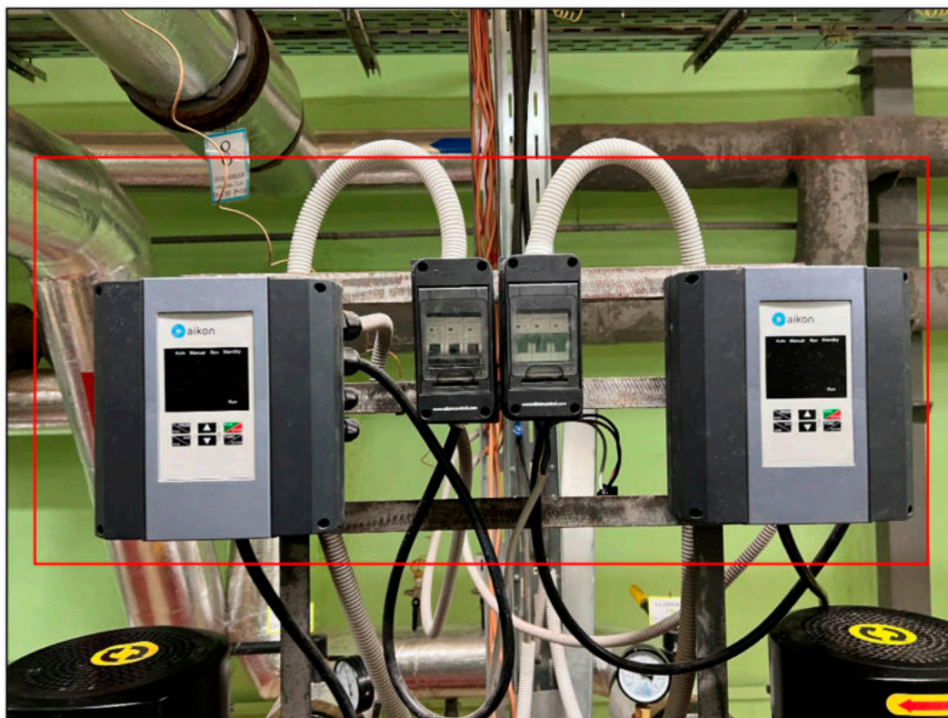
Фото 19. Неработающие частотные преобразователи.
