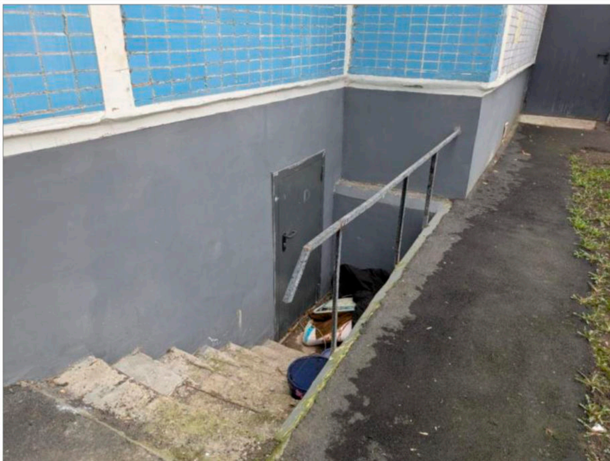
Фото 29. Общий вид прямка входа в подвал.
