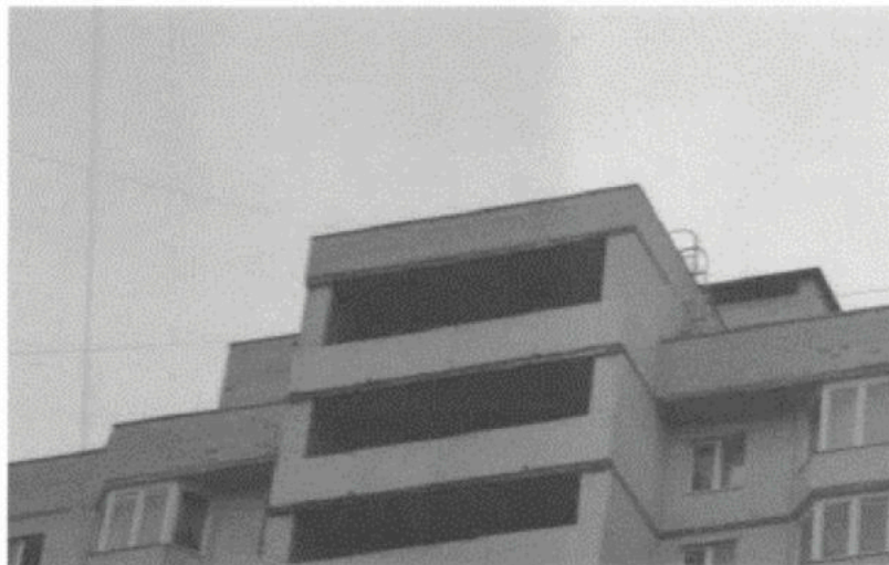
Фото 37 - Общий вид переходных балконов в уровне 15-17 этажей секции 4
