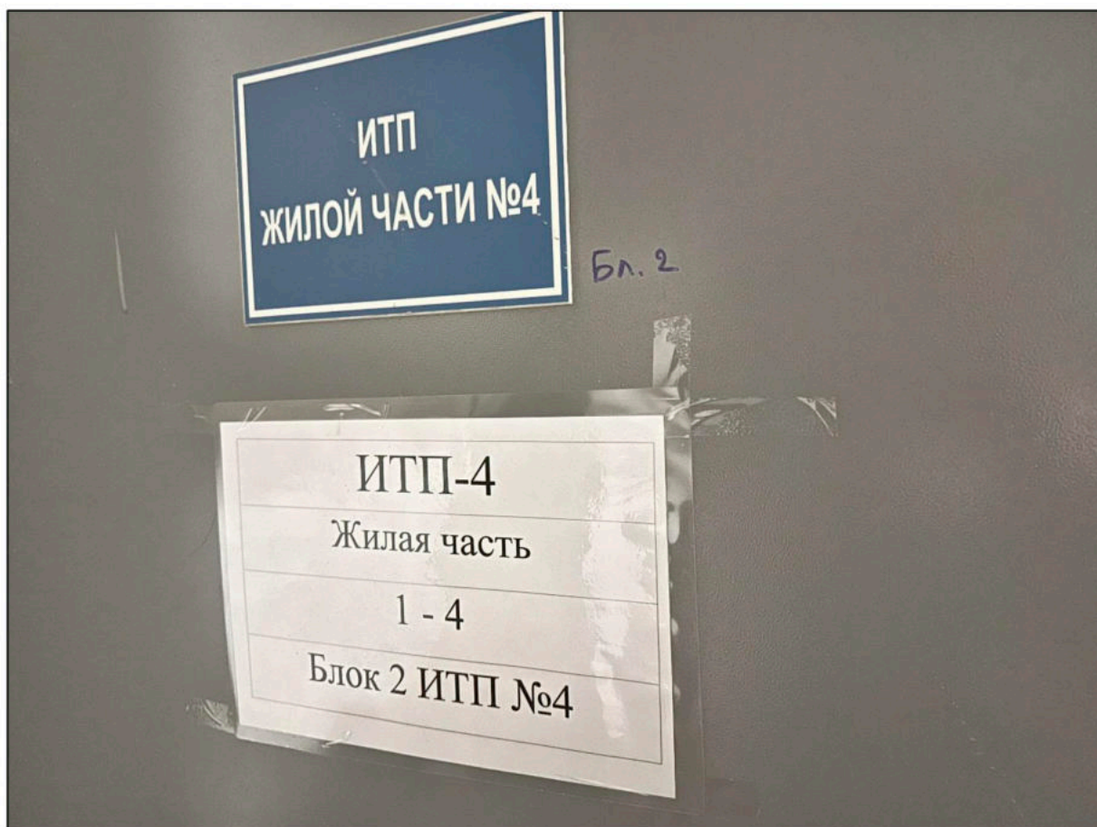
Фото 17. Входная дверь в ИТП жилой части №4. Блок 2 ИТП №4.
