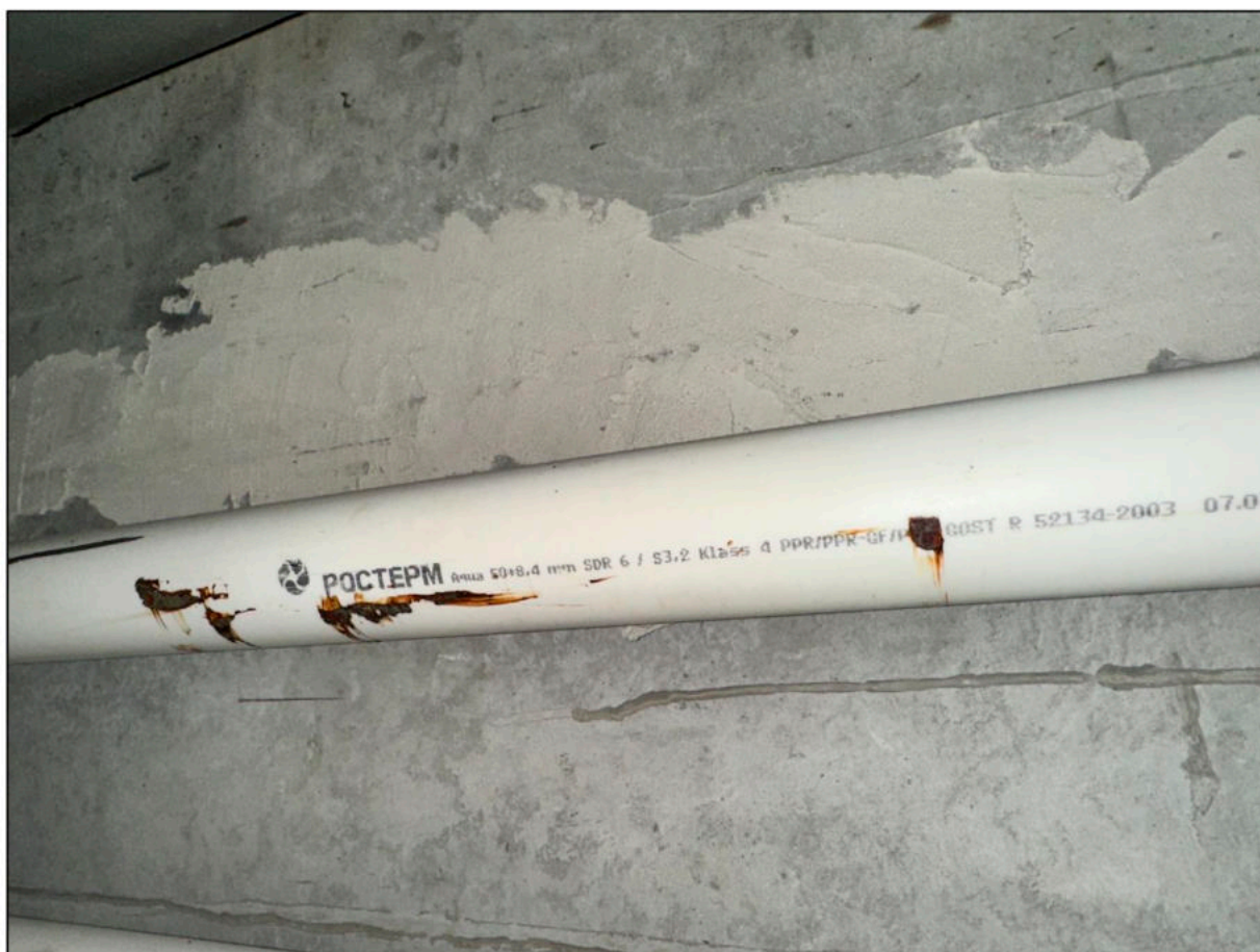
Фото 22. Маркировка смонтированных труб в МКД. SDR 6/Klass 4.
