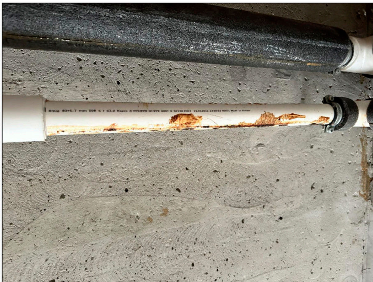
Фото 26. Маркировка смонтированных труб в МКД. SDR 6/Klass 4.
