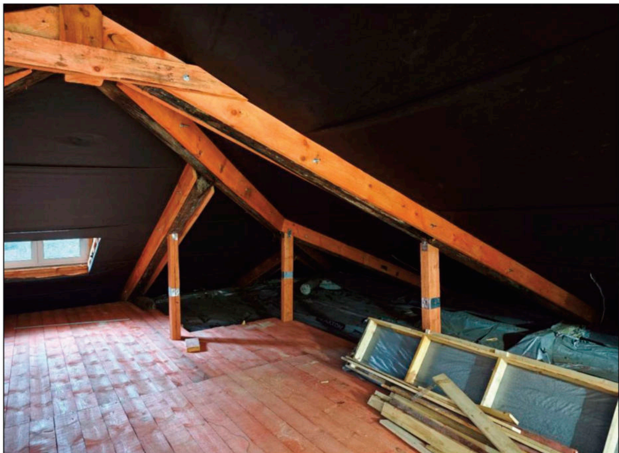
Фото 1. Общий вид стропильных конструкций Объекта экспертизы.
