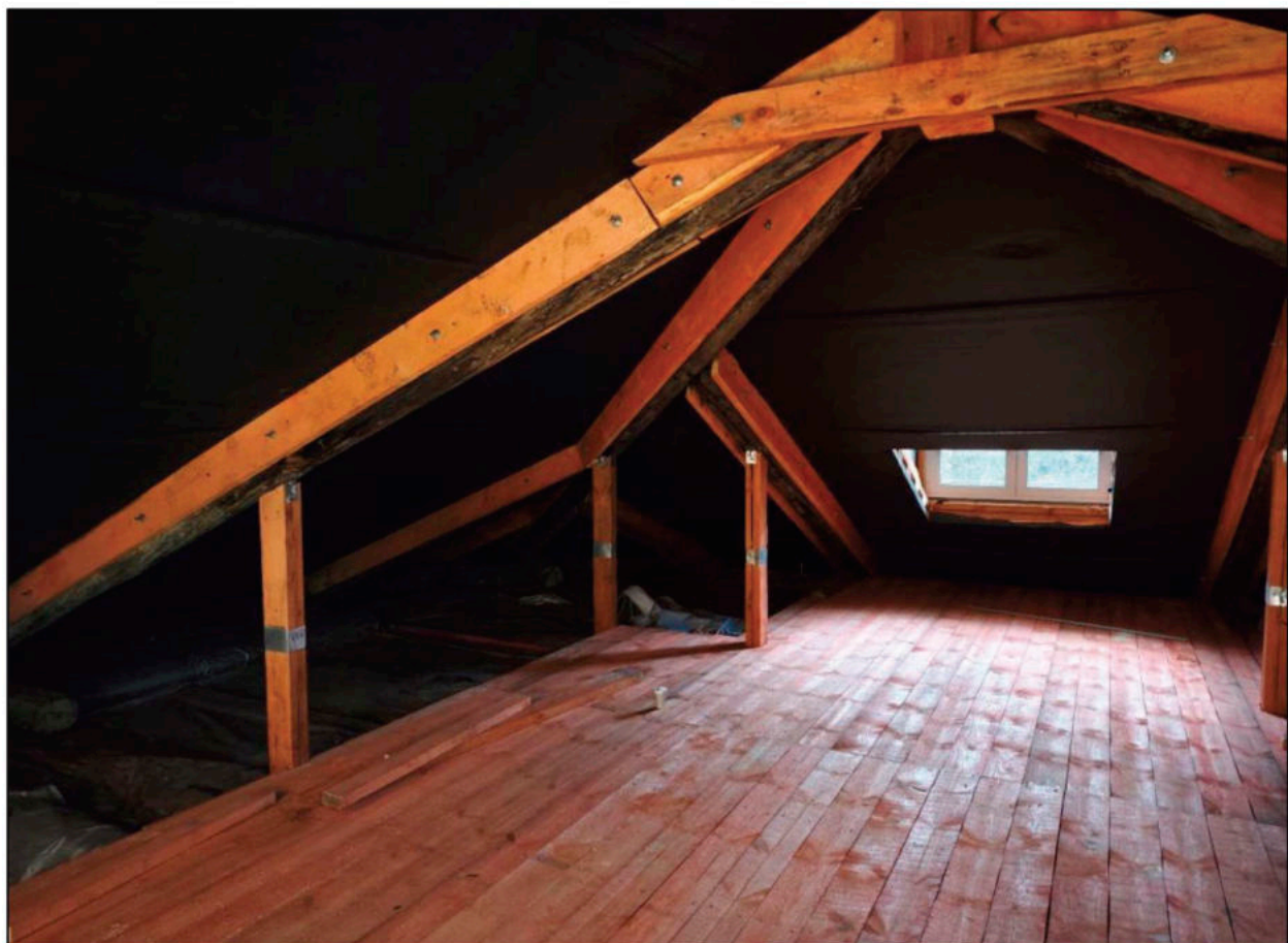
Фото 2. Общий вид стропильных конструкций Объекта экспертизы.
